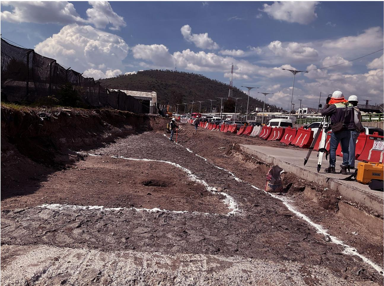
Figura 3. Levantamiento topográfico de la primera sección del camino pétreo.
