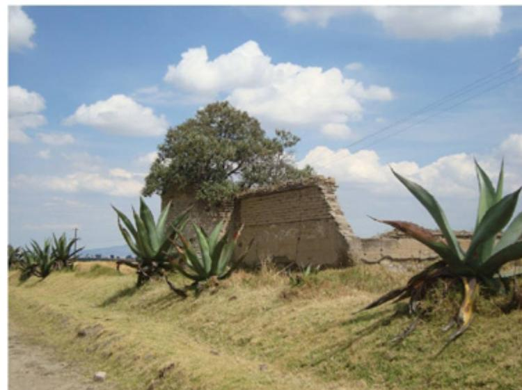
Figura 12. Estado de conservación de muros de tapia con adobe. Fotografía del autor
