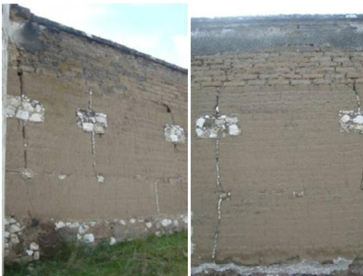
Figura 11. Estado de conservación de muros de tapia con cerramiento de adobe. Imágenes del autor
