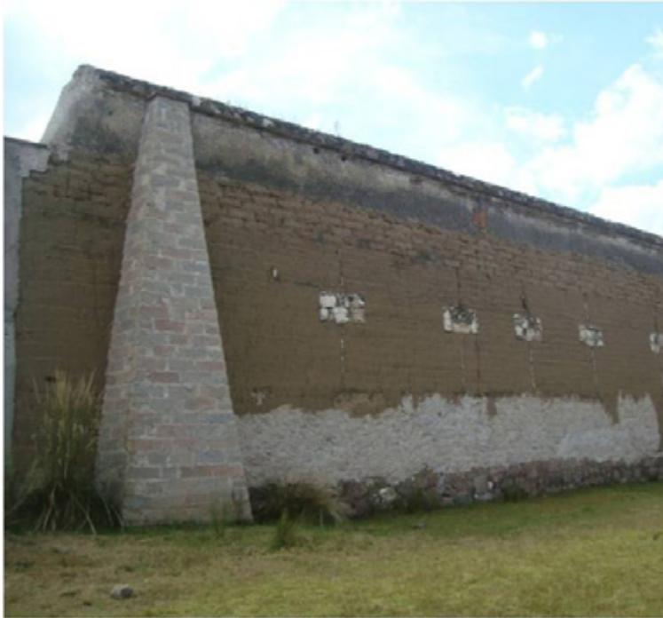
Figura 7. Muro de tapia en la fachada norte de la casa grande.
