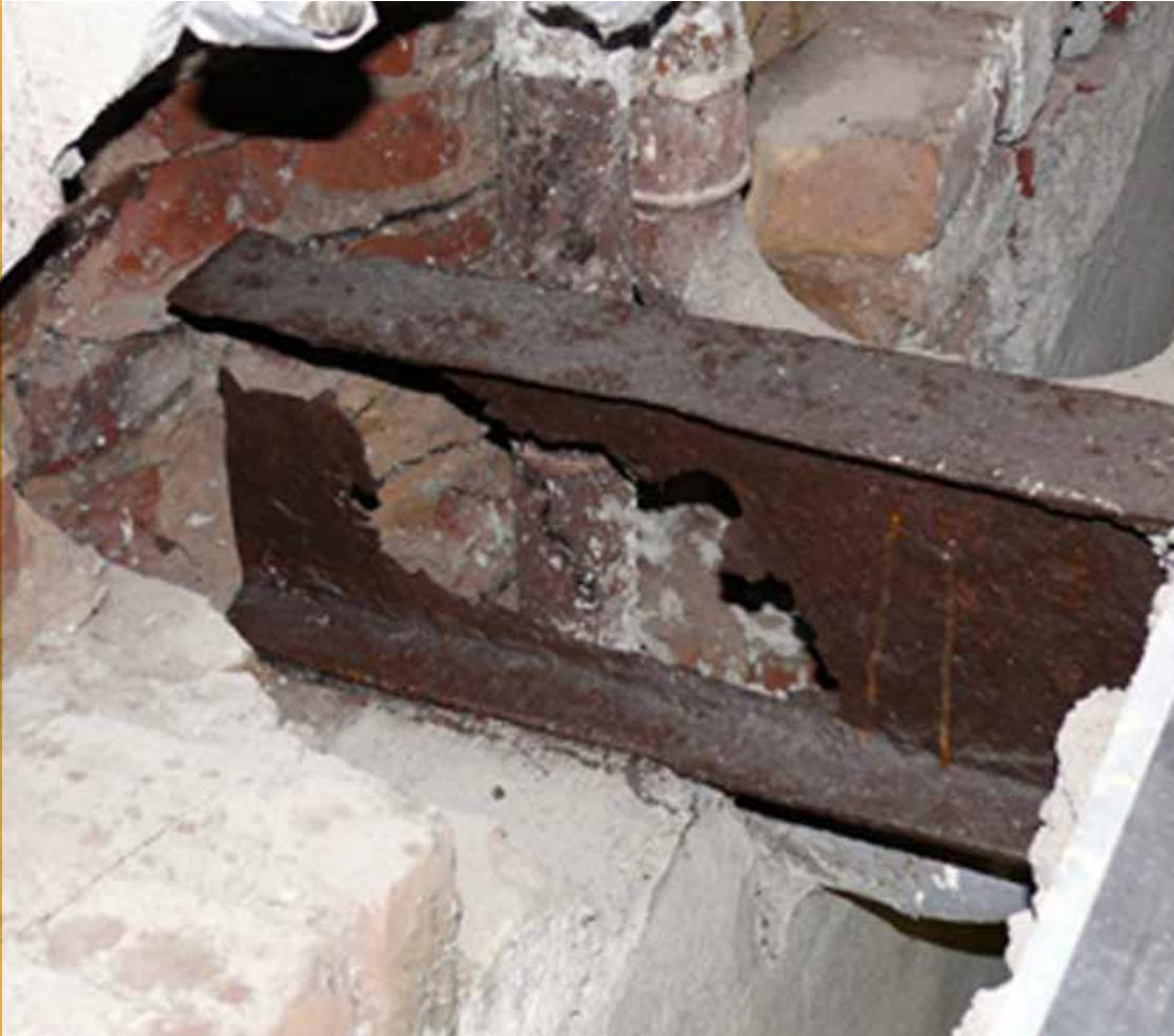
**Figura 6.** Viga corroída que ha causado un impacto en la mampostería produciendo grietas horizontales y perdiendo la junta. Fotografía tomada de: [http://www.isotec.de/uploads/pics/korrodiertes\\_Stahltraeger\\_03.JPG](http://www.isotec.de/uploads/pics/korrodiertes_Stahltraeger_03.JPG).
