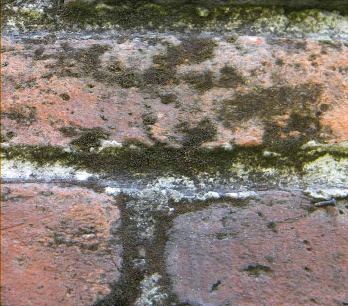
**Figura 5.** Aparición de microorganismos principalmente en las juntas del sistema constructivo. Se puede observar la pérdida de los bordes de las piezas de ladrillo. Fotografías: Martha Ortíz, Coyoacán, 2013.
