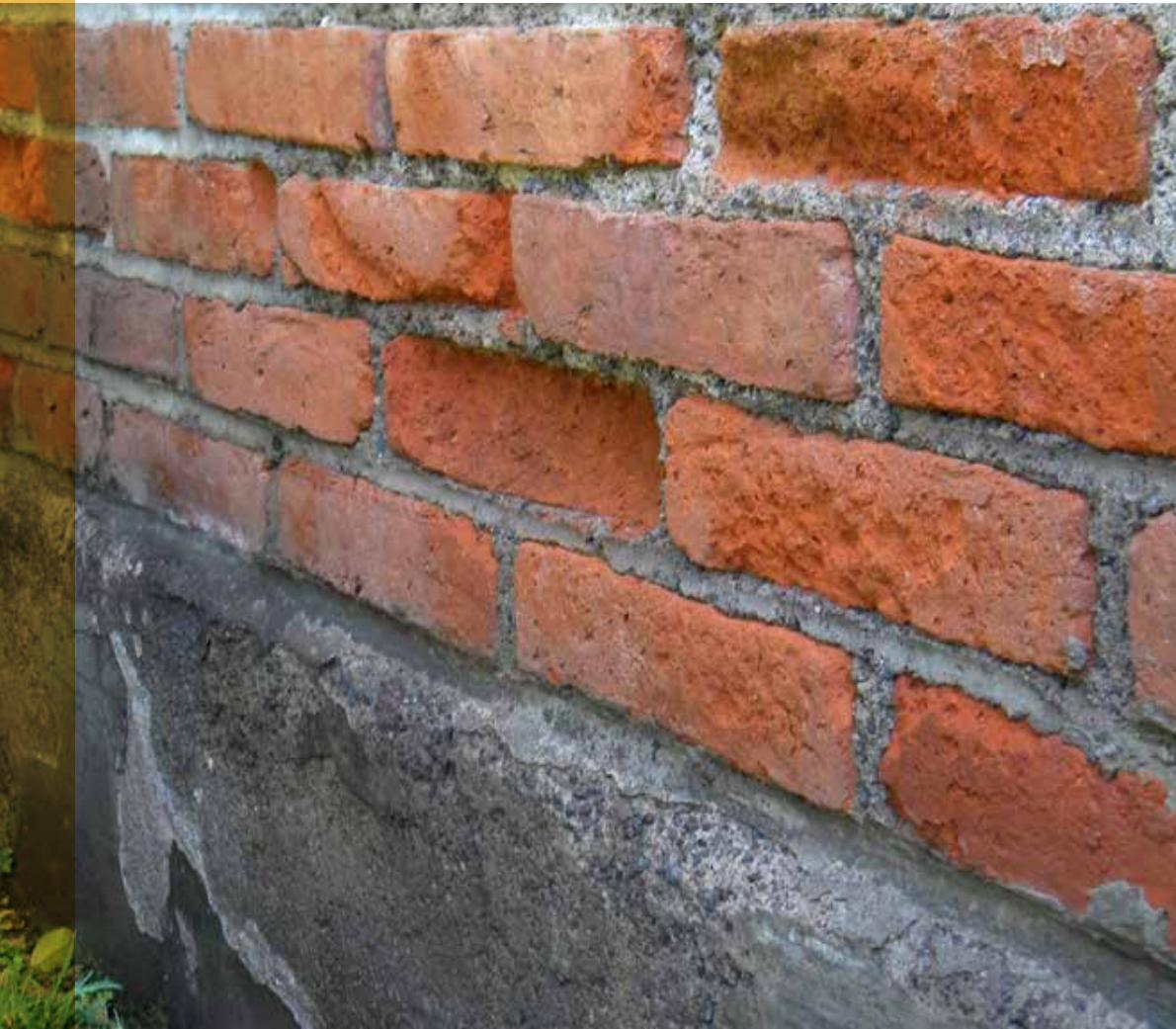
**Figura 4.** Disgregación progresiva del ladrillo y su mortero por acción del agua que asciende por capilaridad.
