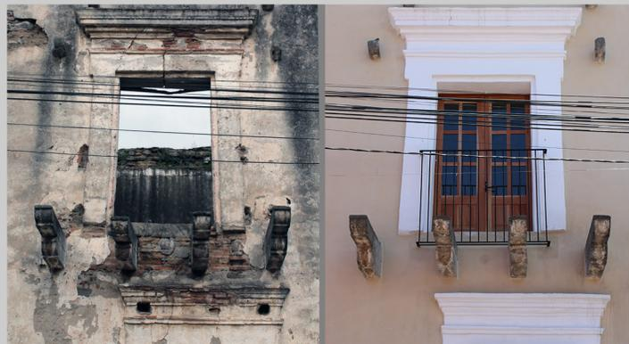
Imagen 21. Deterioro que presentaban los balcones en la fachada lateral oeste
