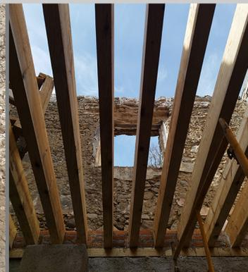
Imagen 16. Colocación de vigería de madera de pino respetando los vestigios existentes
