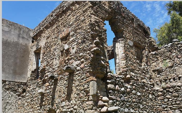
Imagen 9: Vista desde el interior, se aprecia la total pérdida de aplanados y la disgregación de la mampostería
