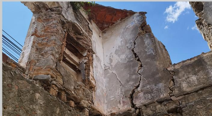
Imagen 10. Vista de fractura en muro, lado noroeste del inmueble
