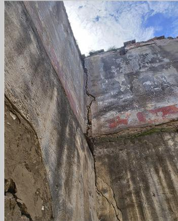
Imagen 13. Grietas en las uniones de los muros
