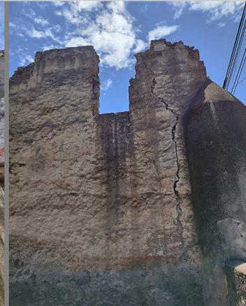
Imagen 15. Fractura en muro, lado norte
