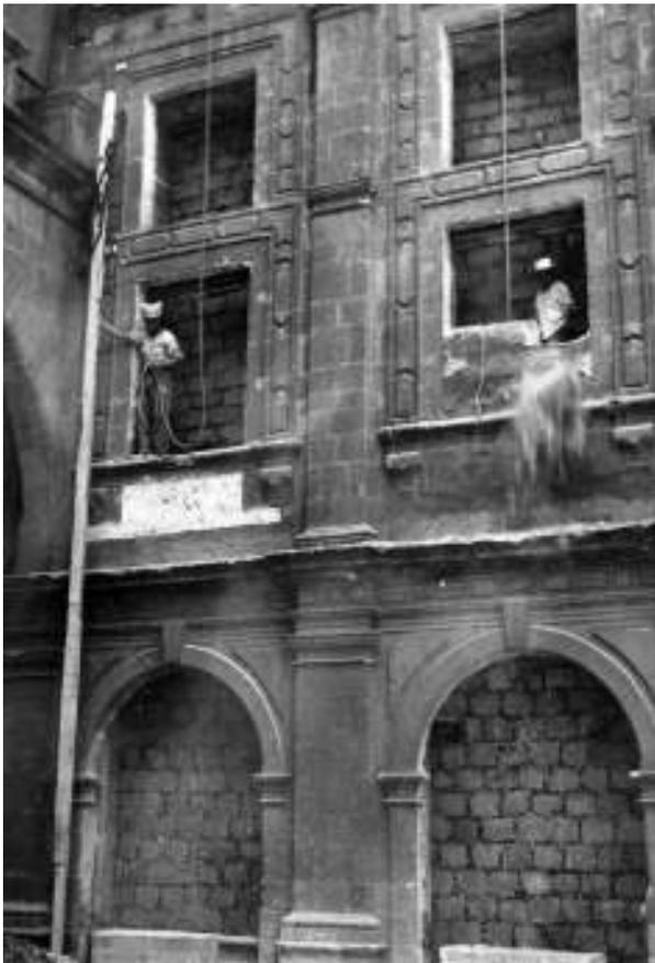
Fotógrafo no identificado. Los trabajos de restauración emprendidos durante la década de 1950 pusieron al descubierto los materiales y los sistemas constructivos utilizados para cegar los vanos de la fachada sur, ca. 1950. Fototeca de la CNMHNAH.
