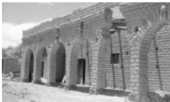
Figura 19. Espléndida construcción con arcada de adobe, como lucía en 1998.
