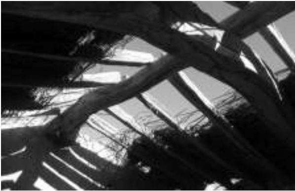
Figura 8. Armazón de cubierta con vigas de algarrobo en una casa de la Finca Potrero.
