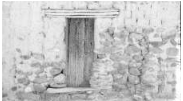
Figura 11. Construcción vernácula de piedra y adobe con dintel y puerta de madera de cardón.
