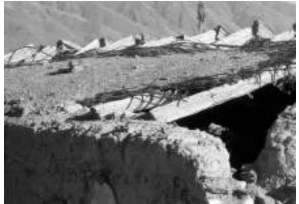
Figura 10. Detalle de una cubierta con la capa de arcilla.
