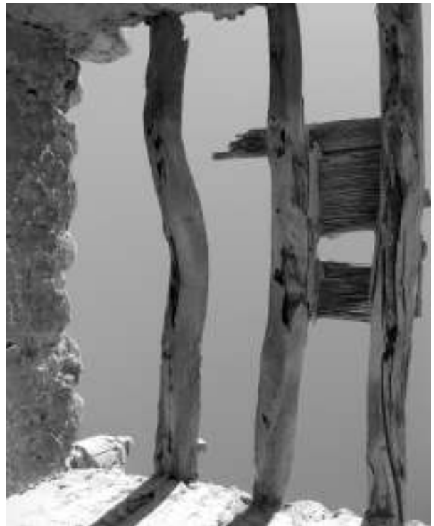
Figura 15. Detalle de las vigas de algarrobo y restos de la cubierta de carrizo de la cripta.
