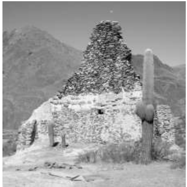
Figura 3. Kallanka inca de Potrero de Payogasta. Nótese la combinación de piedra y tapial. Fotografía de Patricia Carrillo, 2012.
