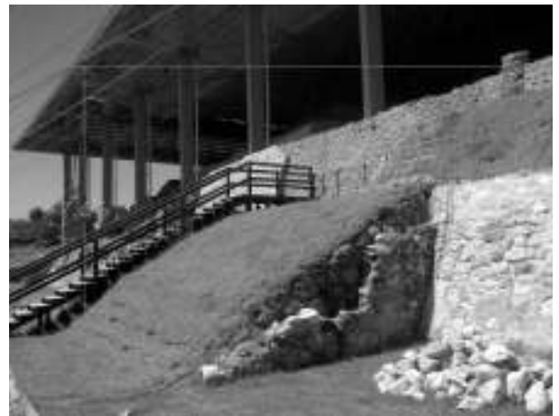
Figura 3. Detalle de la doble altura. Fotografía del arquitecto Víctor Hugo Buendía Herrera.
