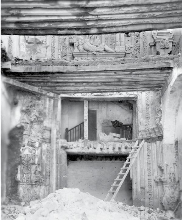
Figura 8. Labores en el ex templo de San Agustín a partir de 1949, las cuales iniciaron con la demolición de las edificaciones que se le superpusieron. En la imagen puede verse que en la fachada lateral se apoyaron algunas losas de entresijo y azotea del edificio erigido hacia 1863. Fuente: CBHC.
