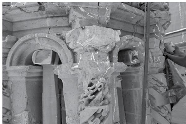
Figura 5. Inyección con marmolina y tezontle rojo en linternilla. Foto: Enrique Rosales Castañeda.<sup>55</sup>
