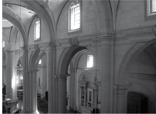
Figura 10. Detalle de columnas y arcos de la catedral de Zacatecas, donde apreciamos el movimiento de la cornisa, ventanas y arranque de arcos formeros. Fuente: Aurea Lorena Lugo Salas, *Fotografía interior de Catedral*, mayo de 2020.
