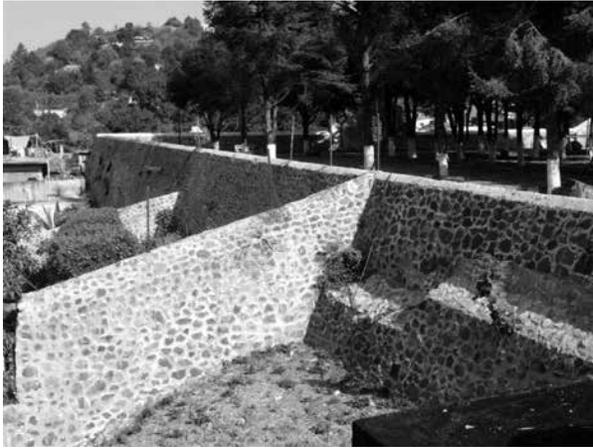
Figura 12. Fachada sur del basamento del conjunto conventual de Tetela del Volcán, en la que se aprecian los muros en escarpe que contienen los rellenos de arcilla. Fotografía de Mario Córdoba Tello.
