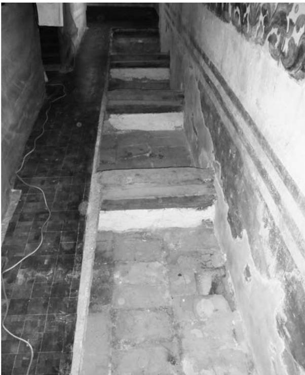
Figura 34. Vista general del sistema constructivo del envigado colocado en el siglo XVIII, después de su estabilización; se observa el piso colocado en el siglo XVII. Fotografía cortesía de Josefina Gasca, 2015.
