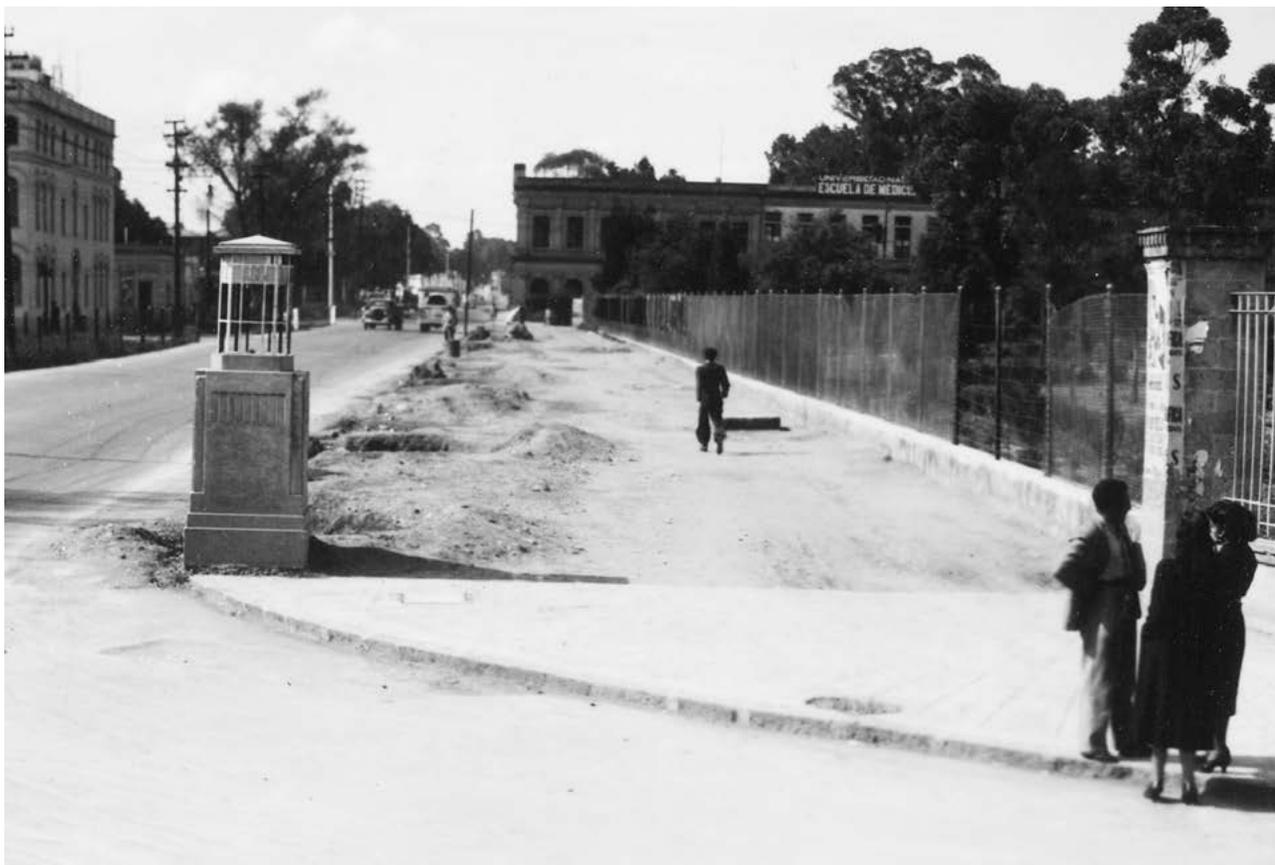
Figura 12. Pavimentación de la ampliación calzada México-Tacuba, octubre de 1939. Fuente: Museo Archivo de la Fotografía.
