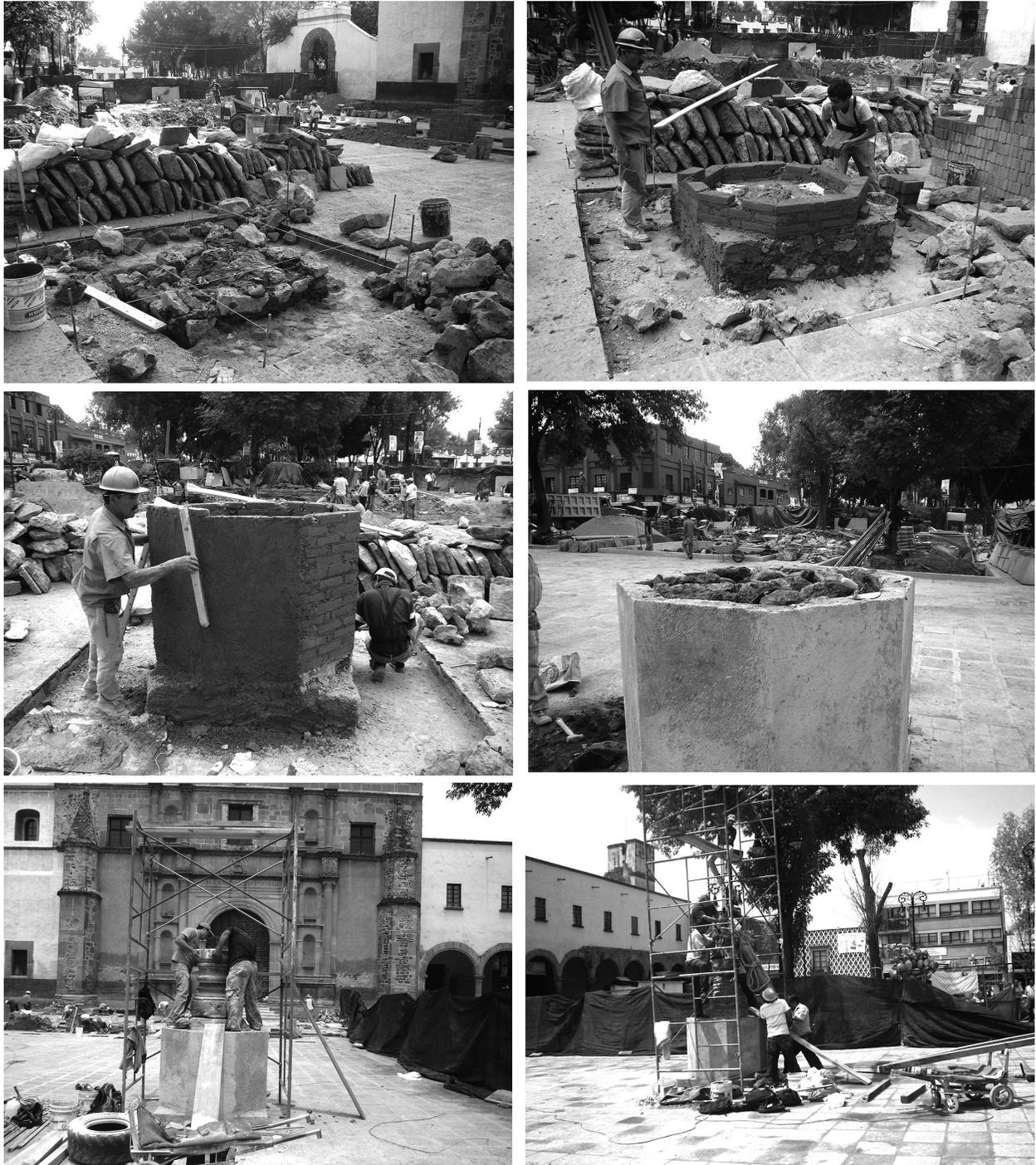
Fig. 4 Construcción del nuevo basamento, apreciándose el sistema constructivo, y colocación de la cruz atrial.
