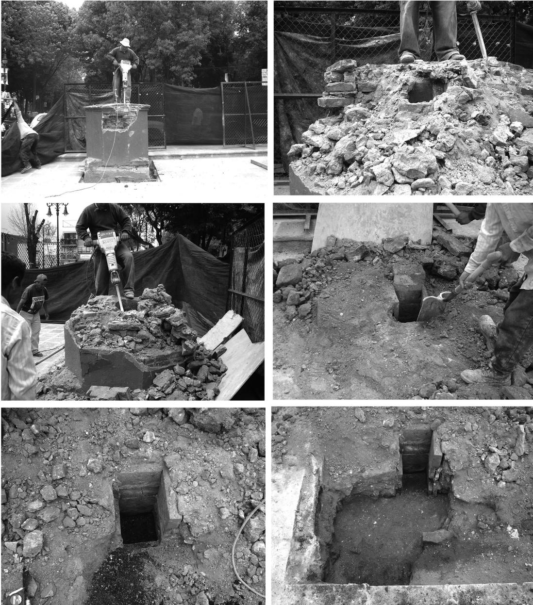
**Fig. 3** Demolición del basamento y registro del sistema constructivo; se aprecia la presencia del tiro en la parte central.
